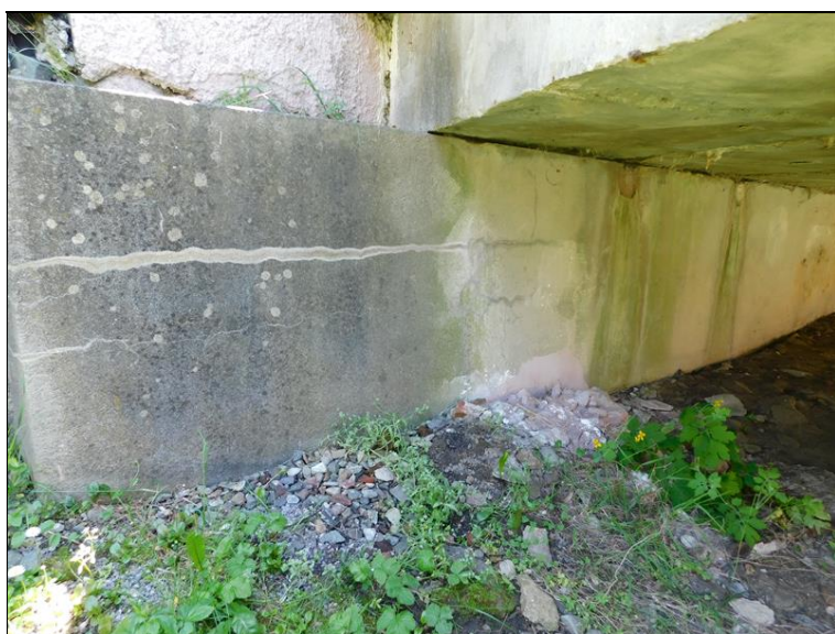
Opěra O1 vpravo - vodorovná trhлина již dříve zapravovaná, znovu prokreslená, další drobné rozvětvené trhliny, stopy po zatékání
