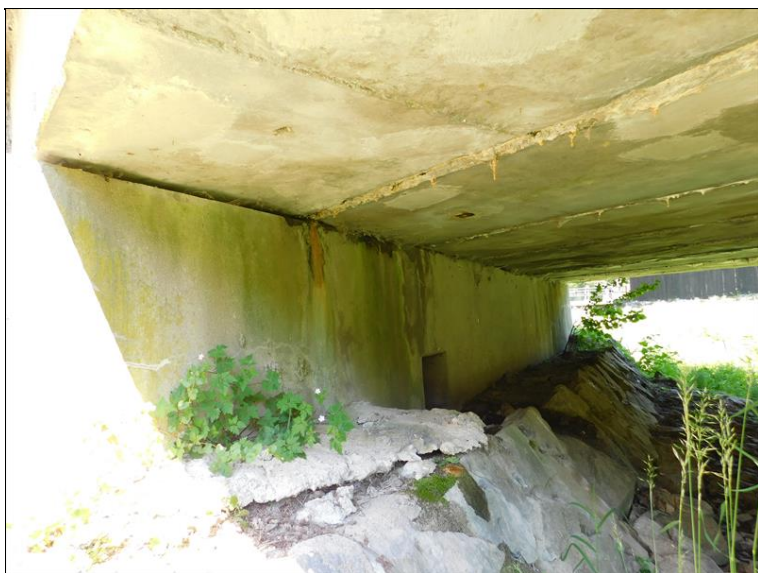
Opěra O2 - stopy po zatékání
