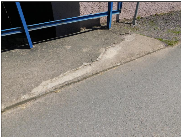
římsa vpravo - plošný odpad povrchové vrstvy betonu
