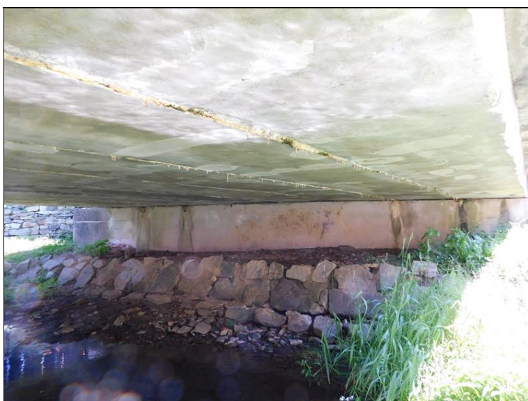
Opěra O1, stopy po zatékání, výluhy, inkrustace
