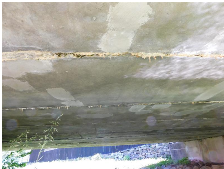
Podhled NK- zatékání spárami mezi nosníky, inkrustace, krápníčky, lokálně provedená sanace
