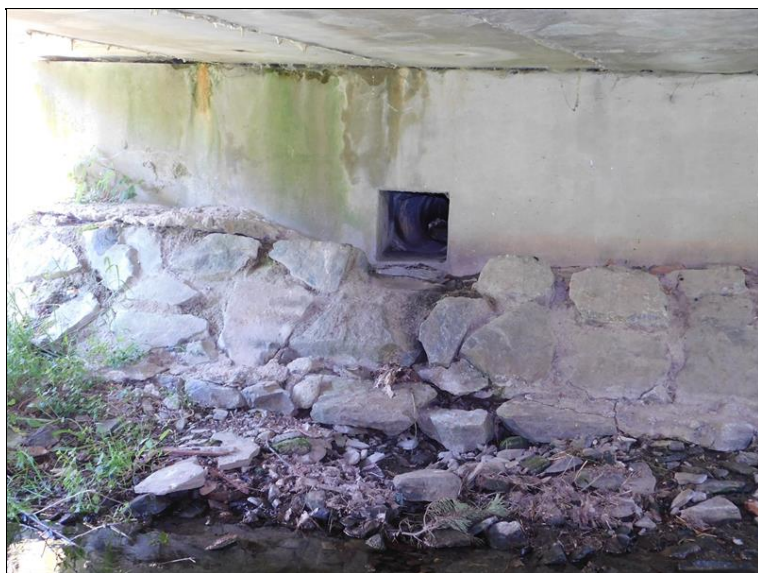
Opěra O2 vlevo - pod vyústěním kanalizace rozvolněné kamenné opevnění opěr
