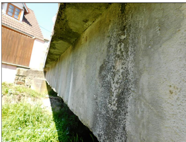
NK zleva - detail - zatékání přes římsu
