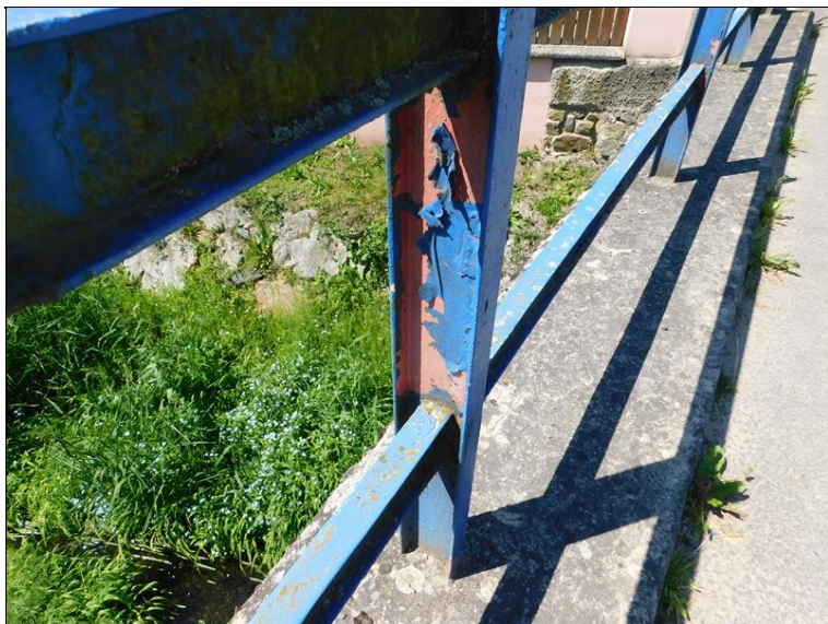
Zábradlí vlevo - detail - olupování PKO
