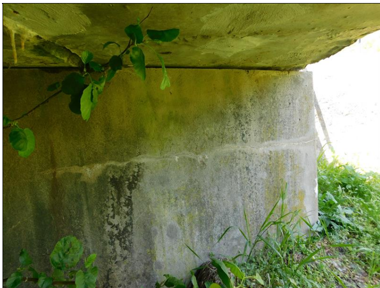
Opěra O2 vpravo - vodorovná trhлина
